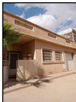
Figure 78: maison existante Source : auteur
