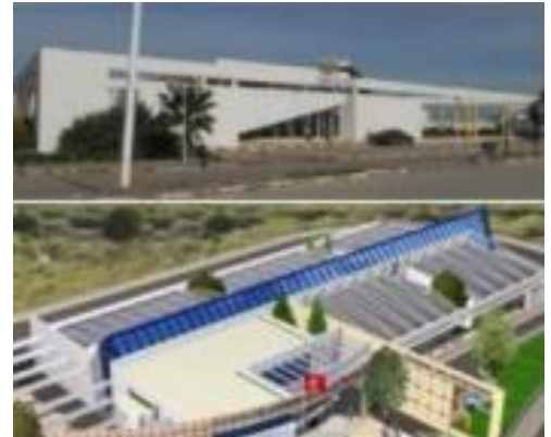
Figure 43 Vues extérieures INNOTEX borj Cedria
