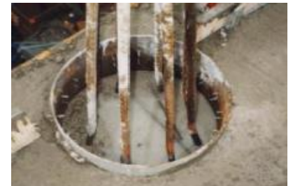
Figure 97 Coffrage poteaux mixte
