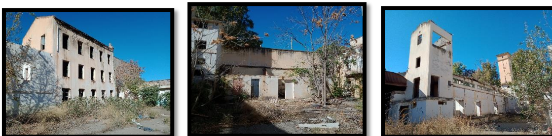
Figure 24. Photos de l'existant sur site 52
