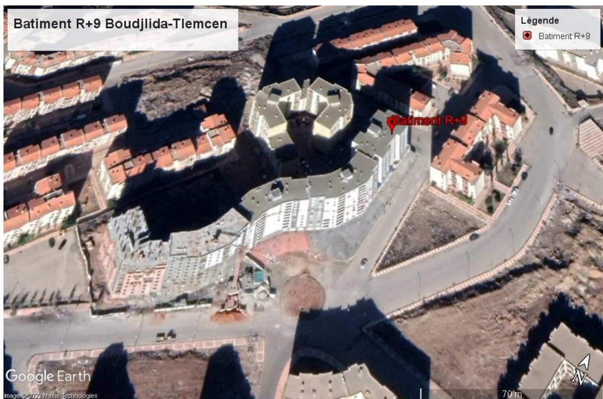
Figure I.1:vue panoramique de l'immeuble (Google earth)
