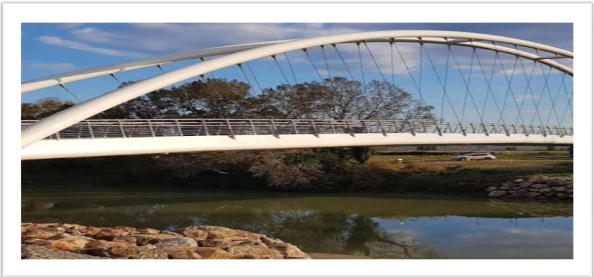
Figure 4 : Passerelle en arc à tablier inférieur.
