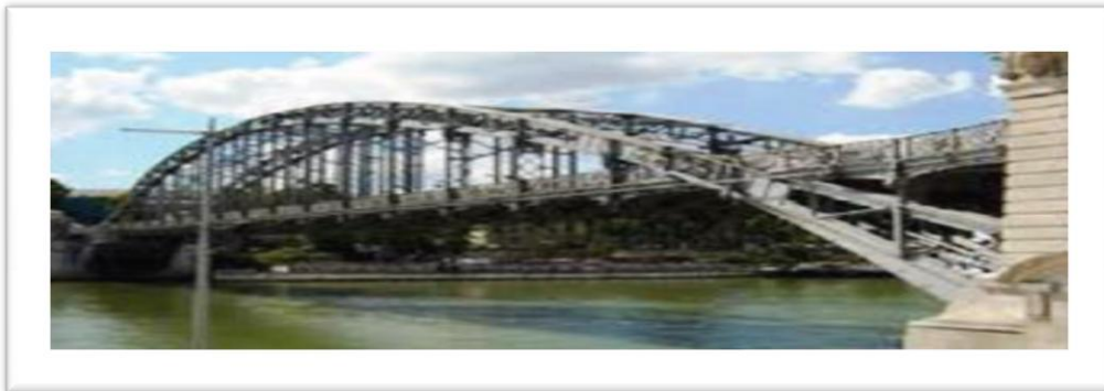
Figure 6 : Passerelle en arc à tablier intermédiaire.
