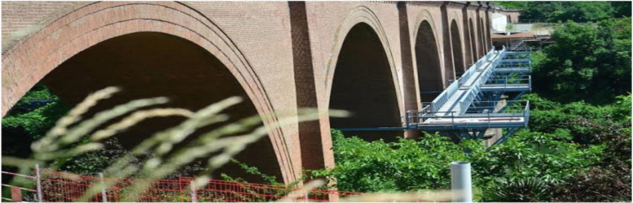
Figure 1 : Passerelle en maçonnerie
