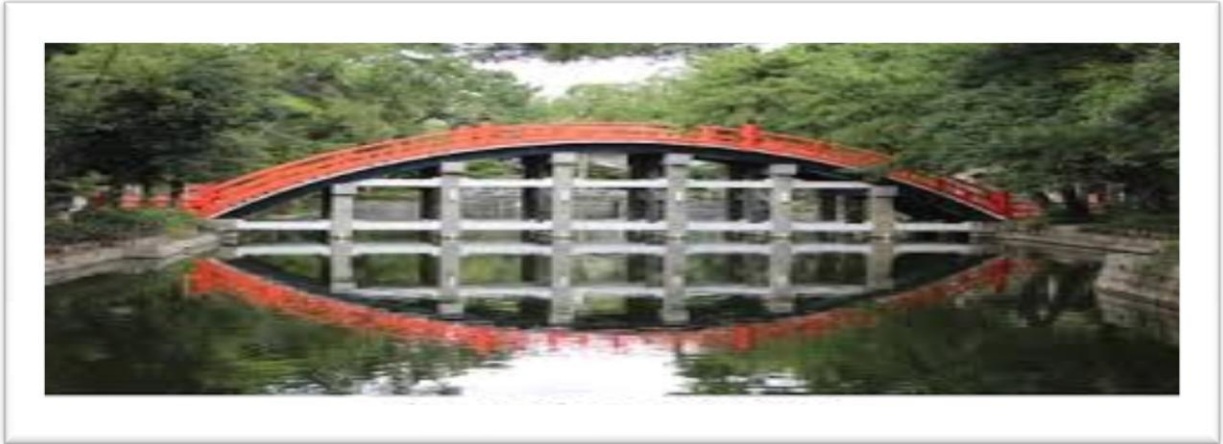
Figure 5 : Passerelle en arc à tablier supérieur.
