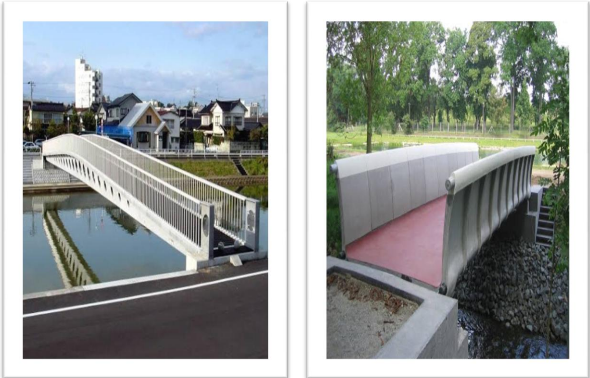
Figure 3 : passerelle à caissons.
