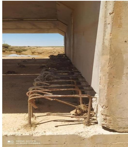
Figure 21 : Clavetage Inférieur
