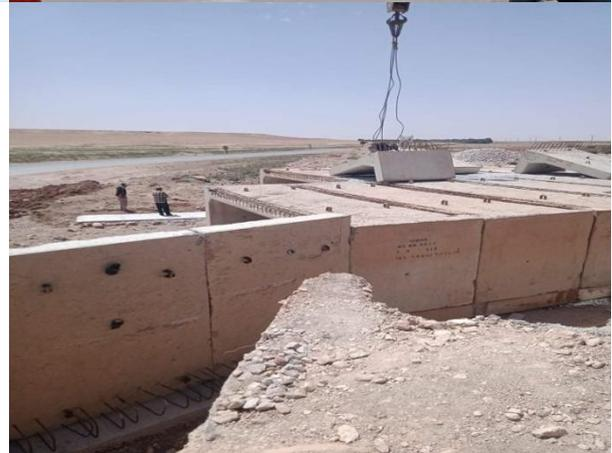
Figure 23 : Les phases de réalisation de nos dalots
