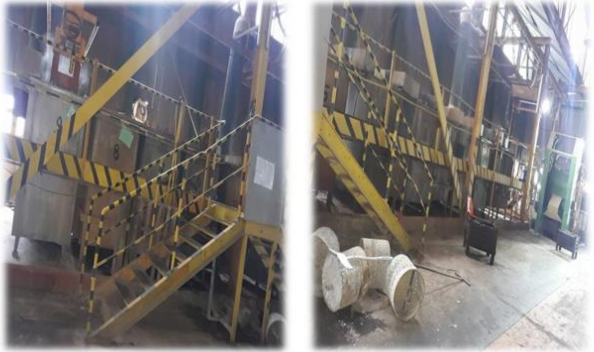
Figure III. 31: la ligne de phosphatage.
