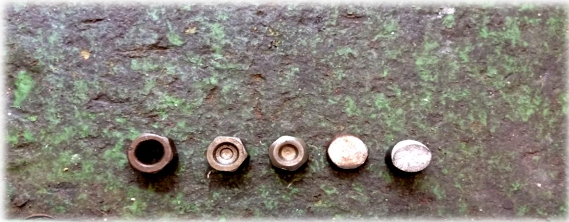
Figure III. 35: L'état des écrous dans les différentes stations.
