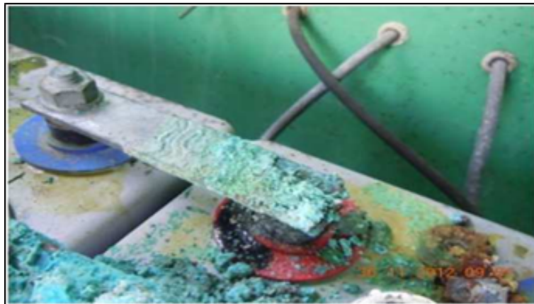
Figure I.26: Phénomène de la sulfatation [8]
