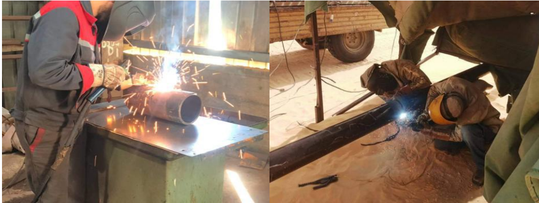
Figure III 7. l'opération de soudage
