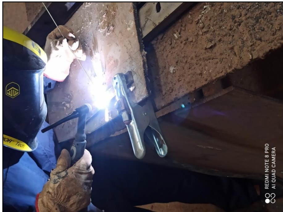
Figure (III.08) : soudage par TIG
