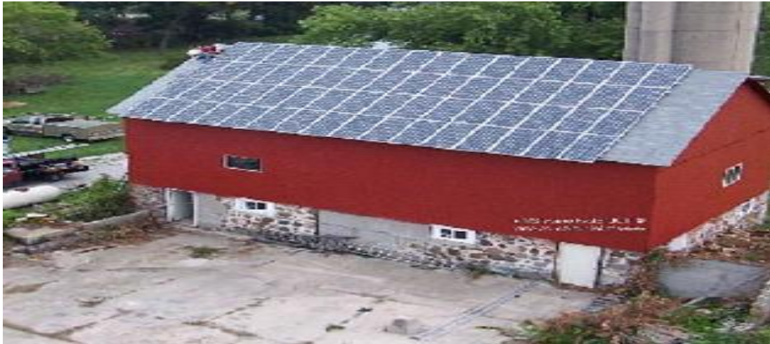
Figure II-2 : Système photovoltaïque monté sur le toit d'une grange. Avec la permission de TDL Electronics[31]
