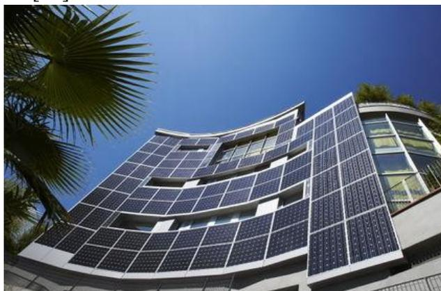
**Fig.II.22** : Panneaux photovoltaïques intégrés aux bâtiments. [57]
