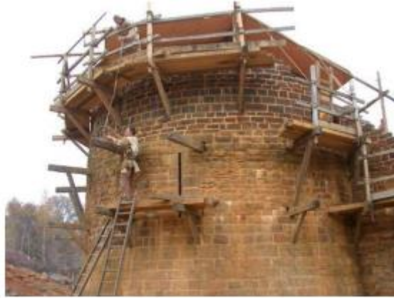
Figure 4: Exemples d'échafaudages en bascule sur le chantier médiéval de Guédelon (Bourgogne)
