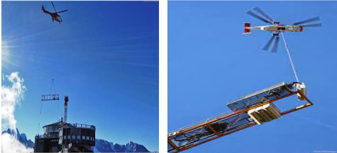
Figure 8 : Hélicoptages pour le montage de grues dans des lieux difficiles d'accès
