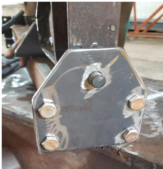
Figure 43 : Assemblage du IPE et tube carré avec une tôle par boulon
