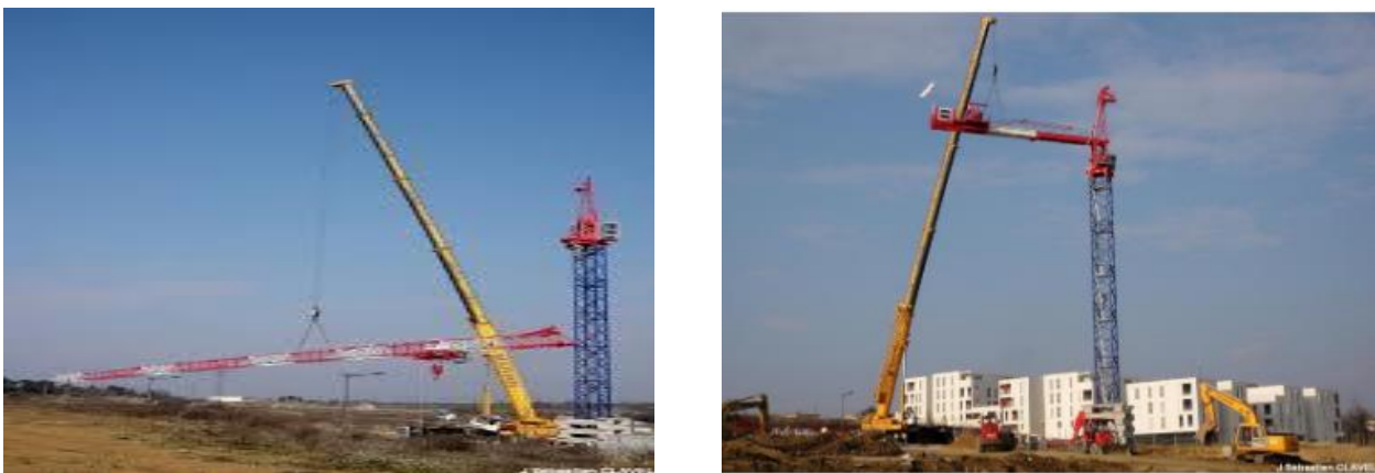
Figure 7 : Montage d'une GME à l'aide d'une grue mobile
