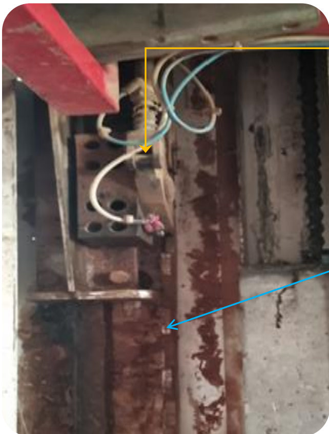
Figure 2-10: Dispositif Anti-Chute Peigne de Sécurité
