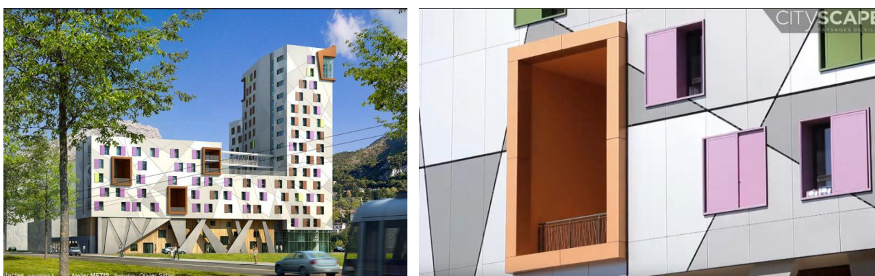
Figure 47. : facade de la résidence espace 49
