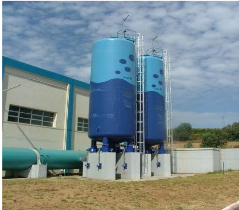
Figure 03 : Réservoir anti-bélier[7]
