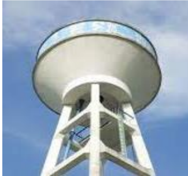
Figure 07 : Ouvrage de stockage d'eau[12]
