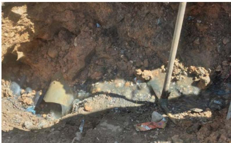
**Figure 2.1 :** Dégradation d'une conduite d'assainissement.
