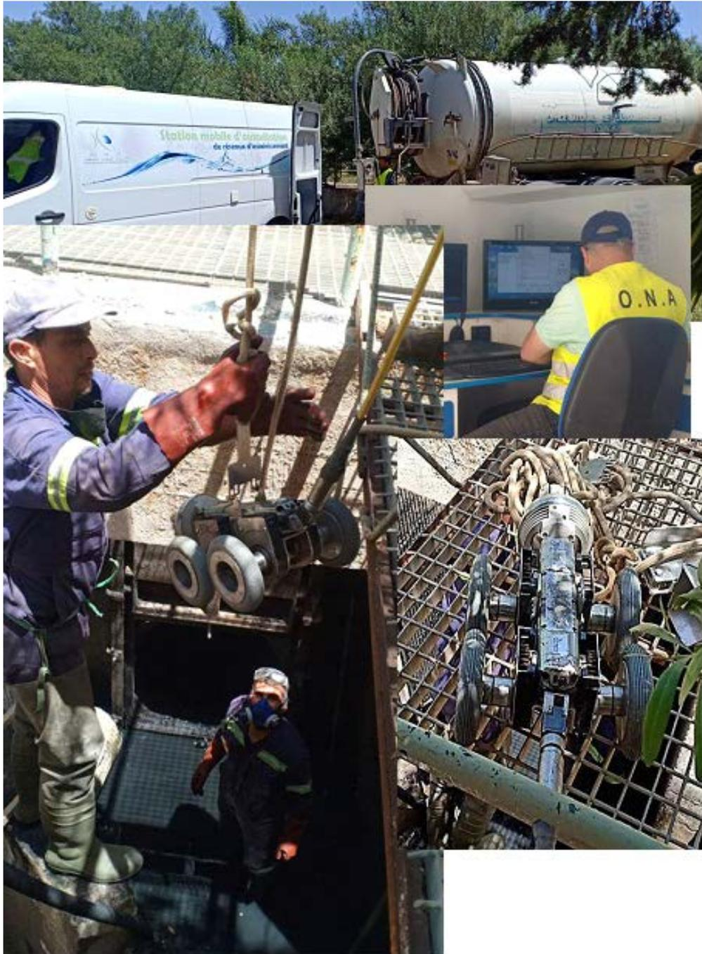
**Figure 2.8 :** Photo d'une opération d'Inspection télévisée réalisé par l'ONA TLEMCEN.
