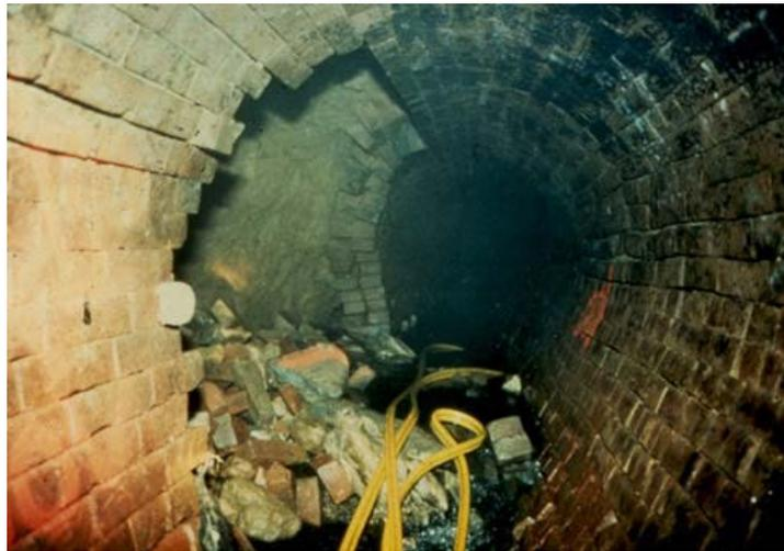
**Figure 2.3 :** Illustration d'un vide important dans le cas d'une conduite en brique. [41].
