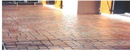
Figure 70: Le béton matricé coloré et en résine minérale projeté 73
