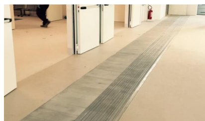
Figure 56 : couvre joint en aluminium 59
