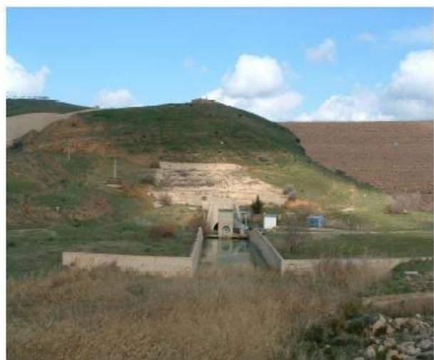
Vue aval sur la sortie du tunnel avec vanne jet creux
