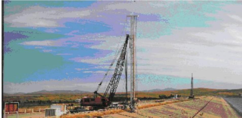
**Figure II.22b** Barrage de Paso de las Piedras - Argentine - 1971 - Ecran étanche réalisé par jet grouting.
