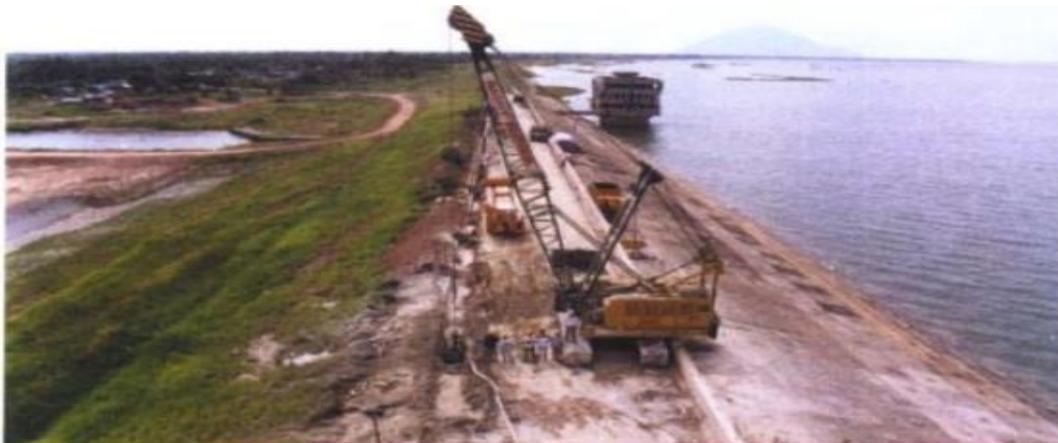
Figure II.21 Barrage de Dau Tieng - Vietnam - 1982 - Excavation de la paroi au coulis.
