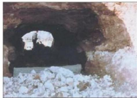
Figure I.15 Renard dans un Barrage (lutrin 2003)
