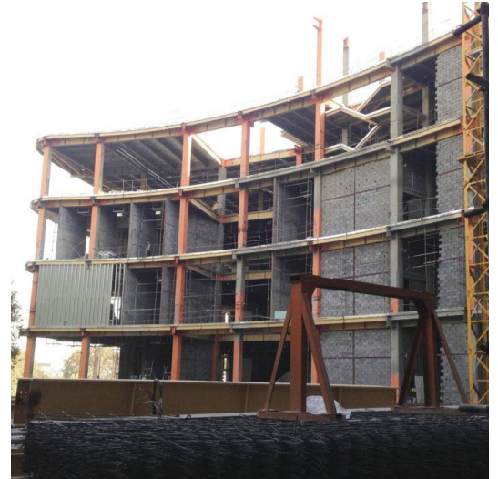
Figure 46 : remplissage de la façade en chantier
