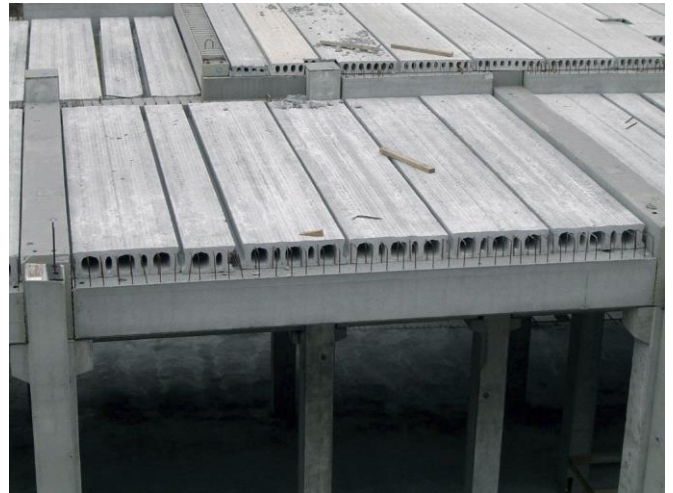
Figure 111 : Dalle de plancher en béton précontraint
