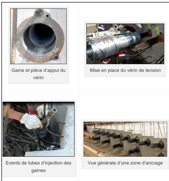
Figure 109 : Le principe de la précontrainte
