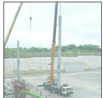
Figure 113 : mise en place des poteaux en béton précontraint
