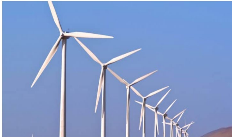
Figure I-4 Photo d'une centrale éolienne [9]
