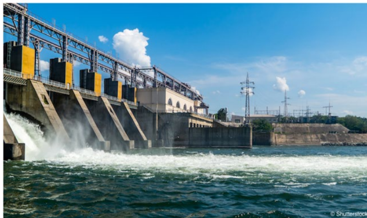
Figure. I -3 Photo d'une centrale hydroélectrique [8].
