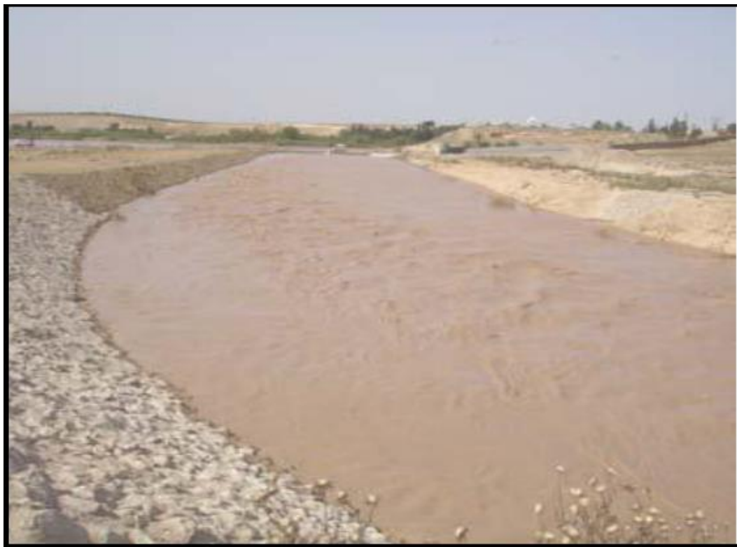
Figure II.17 : Canal de dérivation au Sud de la ville de Sidi Bel Abbés (Hallouche, 2007).
