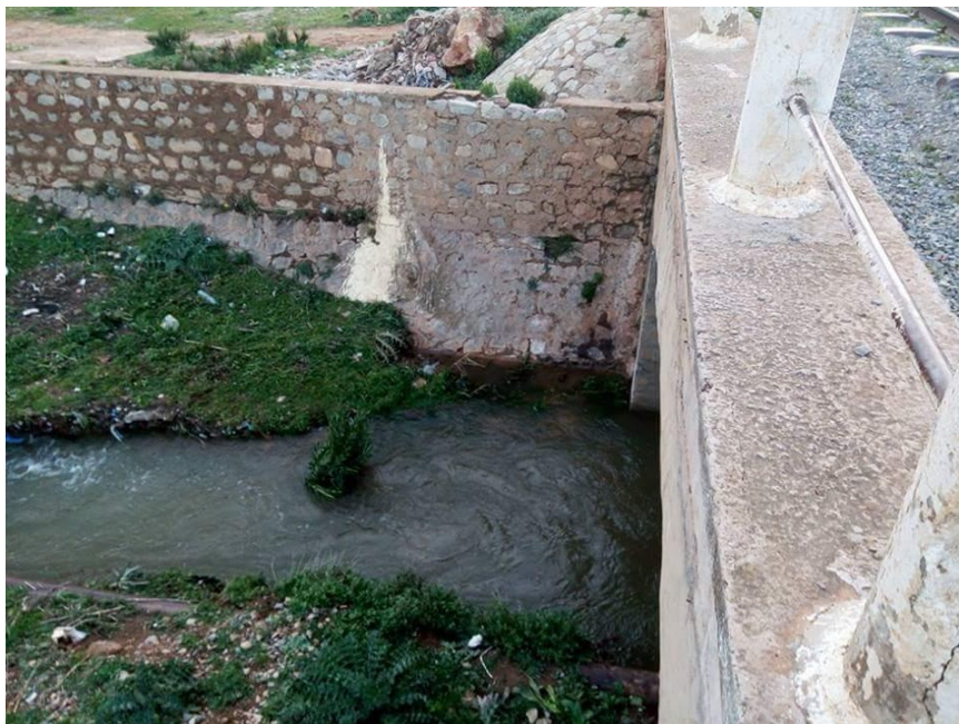
Figure III.8 : Arrivée de l'eau au niveau de traversée de chemin de fer (19/04/2016)
