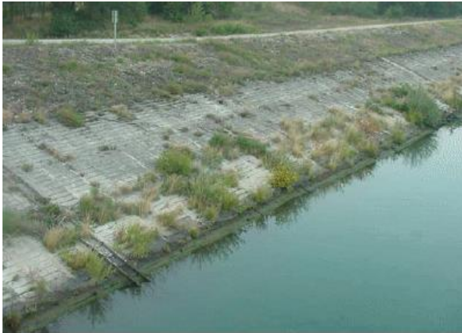
Figure II.3 : Digue de navigation du Rhône en charge en permanence (Mériaux, 2001).
