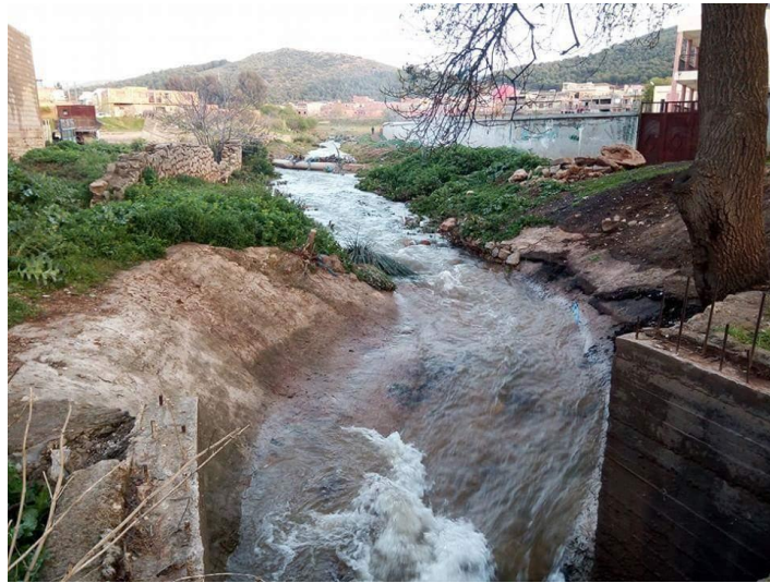
Figure III.6 : Arrivée de l'eau au niveau de la galerie (19/04/2016)
