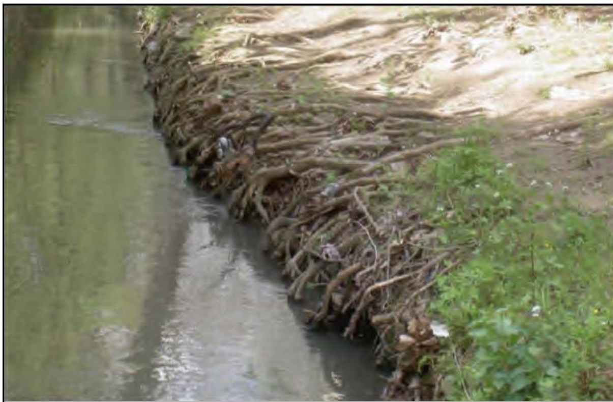
Figure II.8 : Aménagement des berges de l'oued contre le glissement ( Halouche, 2007 ).
