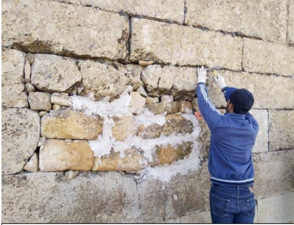
الصورة رقم 110: ملئ الفجوة الموجودة في الواجهة الغربية
