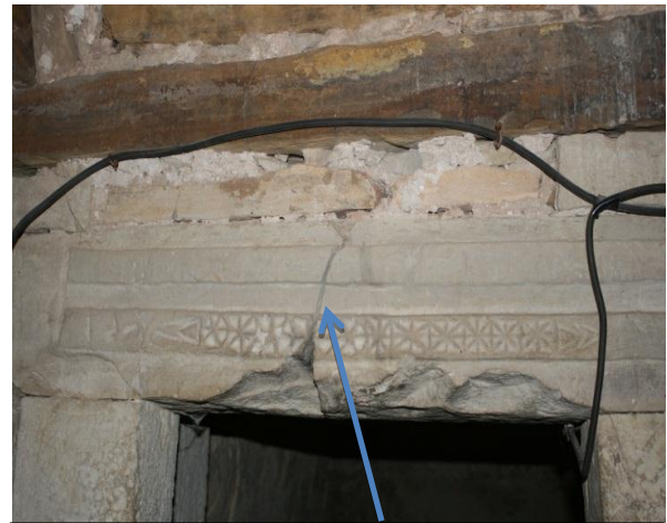
الصورة رقم 60: تشقق الحجارة التي تحمل النقوش
