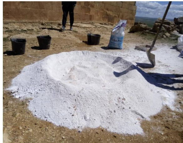
الصورة رقم 97: عملية تحضير الملاط ( مادة الربط)
