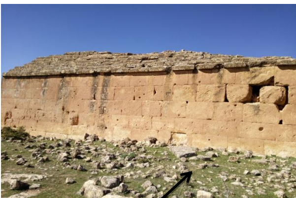
الصورة رقم 182: أنقاض بناء مربع أمام المعلم الثالث
