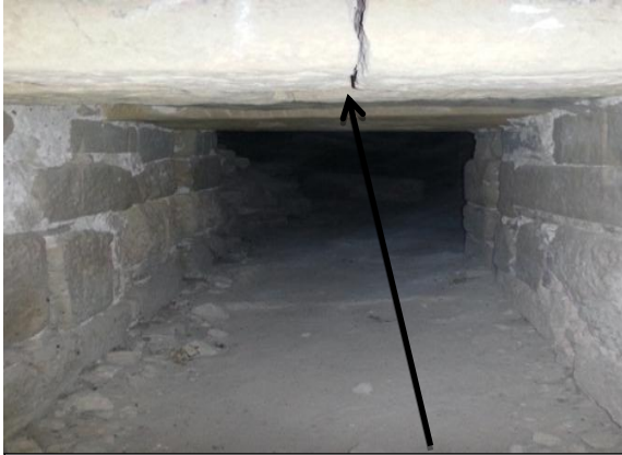
الصورة رقم 77: تشقق الحجارة المستعملة كعوارض في الأروقة
