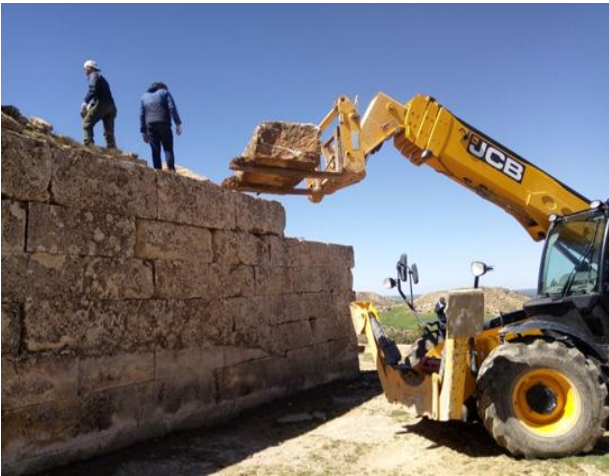
الصورة رقم 94: عملية رفع الحجارة بواسطة الرافعة الميكانيكية
