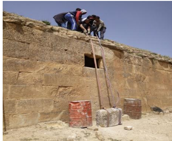
الصورة رقم 93: عملية رفع الحجارة بواسطة الحبال
