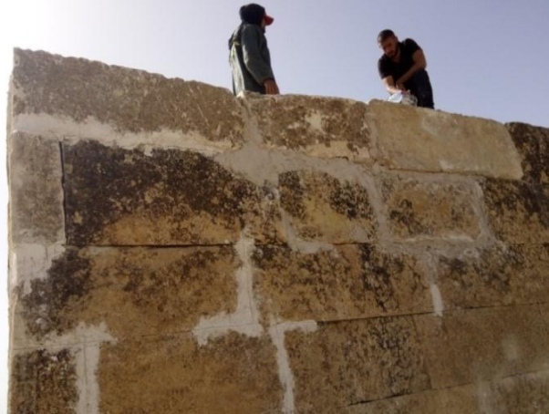
الصورة رقم 99: عملية إعادة بناء الحجارة المتساقطة
