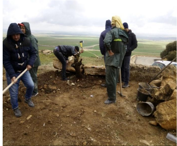
الصورة رقم 87: عملية تنظيف الموقع
