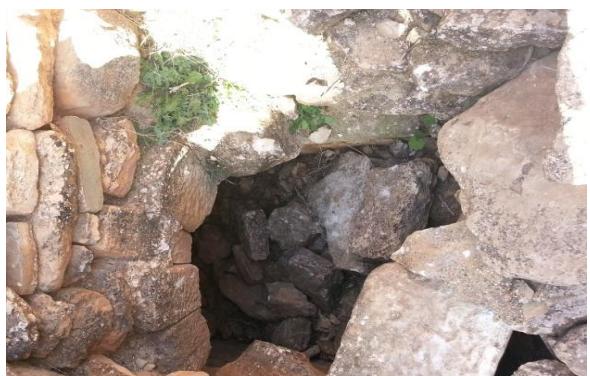
الصورة رقم 206: نفق على يسار المدخل
