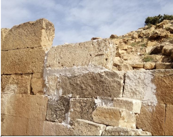
الصورة رقم 102: منظر للجدار بعد استكمال بنائه
