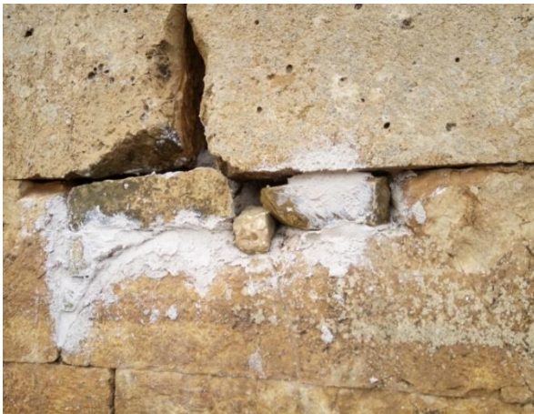
الصورة رقم 98: عملية سد الفراغات الموجودة بالجدران
