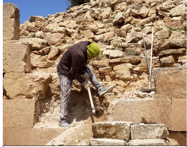
الصورة رقم 101: نزع الحجارة والأتربة من جدار المدخل
