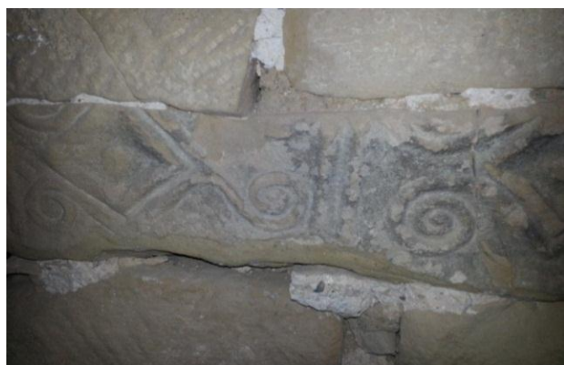
الصورة رقم 74: تقشر سطح الحجارة التي تحمل النقوش
