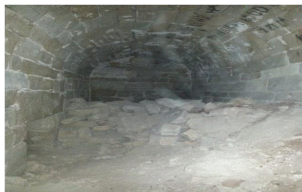
الصورة رقم 215: الغرفة الثالثة
