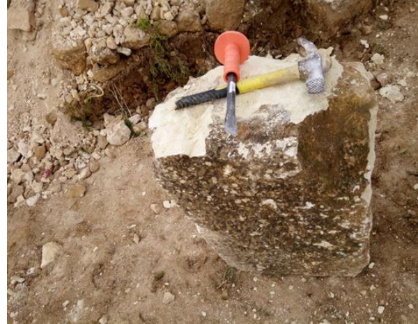
الصورة رقم 95: عملية صقل الحجارة بالمطرقة والإزميل
