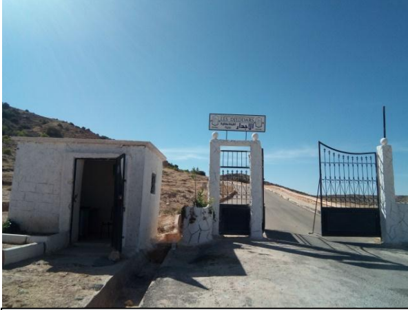
الصورة رقم 116: البوابة ومركز الحراسة بالمعلم الأول بجبل لخضر
