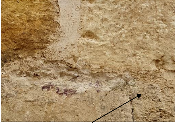
الصورة رقم 112: تشقق وتقشر الحجارة بعد استعمال الإسمنت
