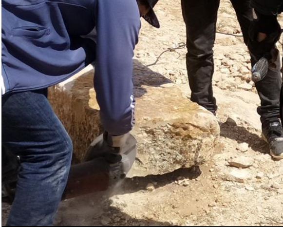
الصورة رقم 96: عملية صقل الحجارة بالقاطعة الكهربائية
