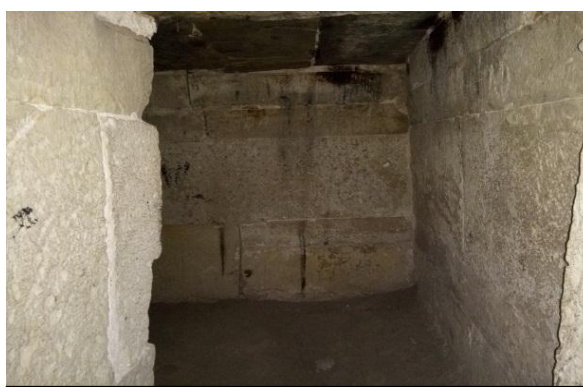
الصورة رقم 145: الغرفة الثالثة
