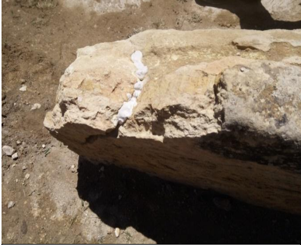
الصورة رقم 106: وضع الملاط لتثبيت الجزء المكسور
