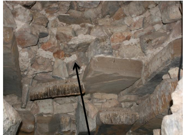
الصورة رقم 56: انهيار السقف عند مدخل المعلم الأول
