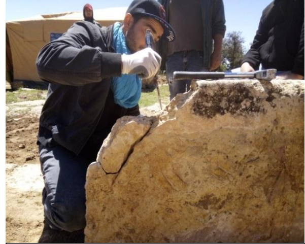
الصورة رقم 105: تنظيف الحجارة قبل ترميمها
