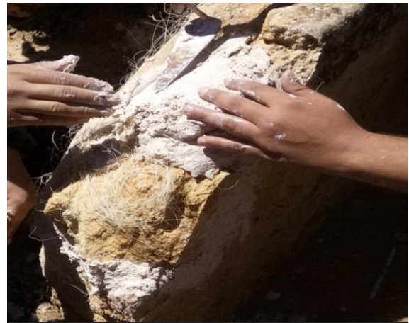
الصورة رقم 107: وضع ألياف النخيل مع الملاط
