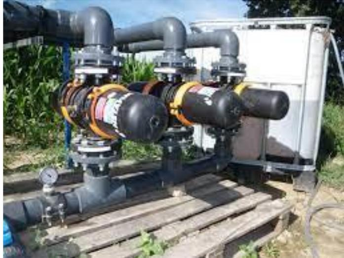
**Figure 2.8 : Unité de tête (Bac, Pompes, Vannes et Manomètres)**
