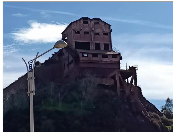
Figure 61. Le culbuteur en hauteur
