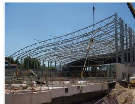
**Figure 62 :** La charpente se compose de 34 fermes treillis fines et galbées
