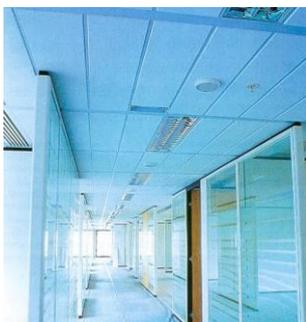
**Figure 117: faux plafond en Placoplatre**
