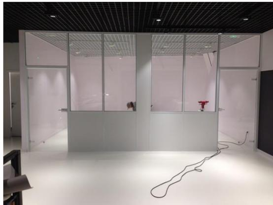
**Figure 113: exemple de cloison semi-vitré**
