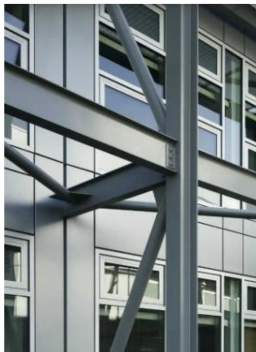
**Figure 77 :**Exosquelette en acier ; augmente résistance sismique du bâtiment
