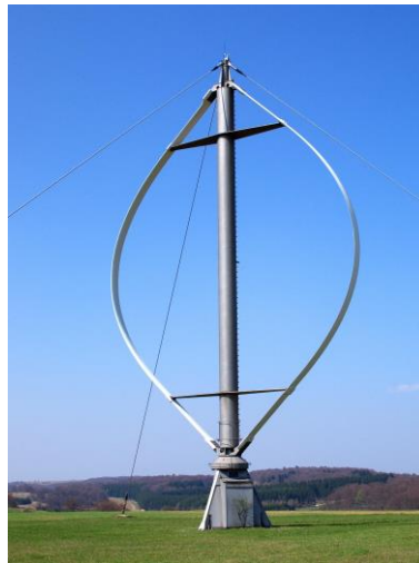
Figure 2.5: Éolienne de Darrieus.
