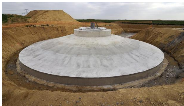
Figure 2.9: Fondation des éoliennes.
