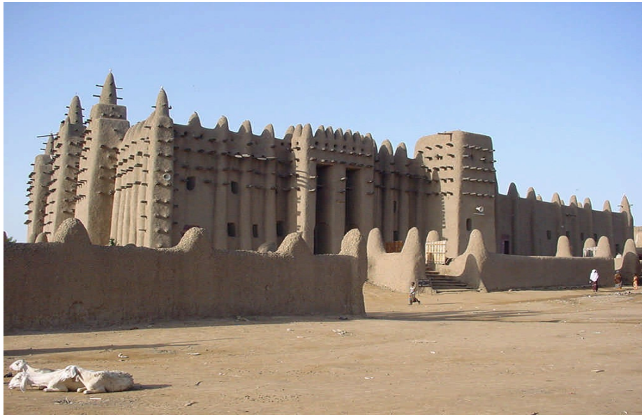
Figure 1.3 : La Grande Mosquée de Djenné au Mali construite en adobe (Delbecque, 2011)
