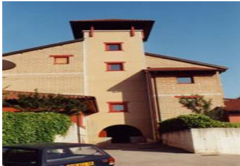
Figure 1.8 : Maison construite en BTC à Rhône en Alpes (Rigassi, 1995).
