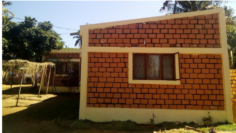
Figure 1.31 : Maison construite en BTC à Rwanda.
