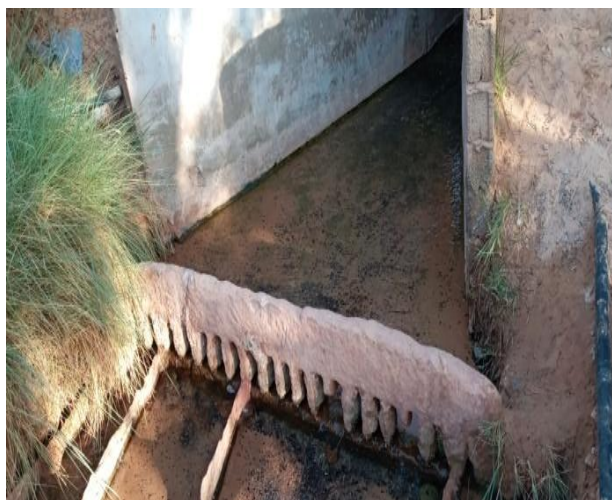
Photo1: Kasria principale de la fogarra de El mechraà
