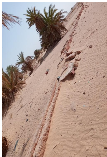
Photo 3 : Sèguias dégradée d'une foggara
