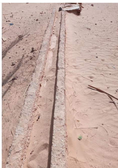
Photo 3 : Sèguias dégradée d'une foggara
