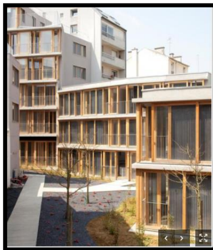
Figure 15 : Un immeuble bioclimatique
