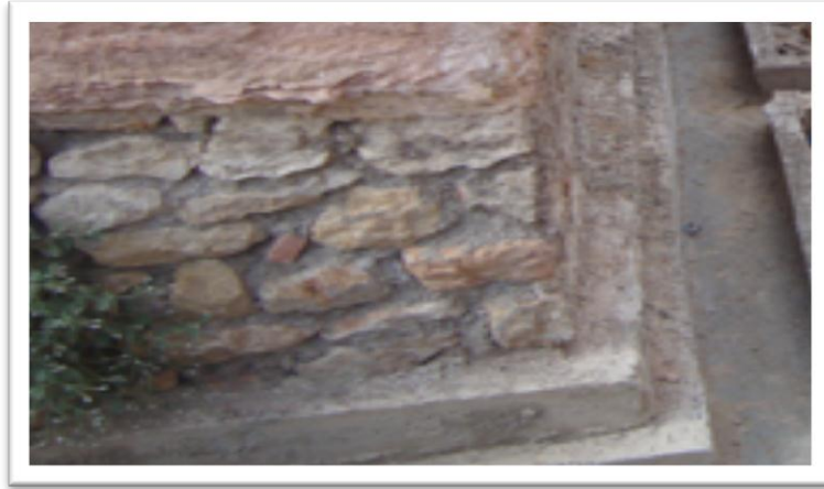
Figure 42 : reprise sous œuvre bloc d'entree
