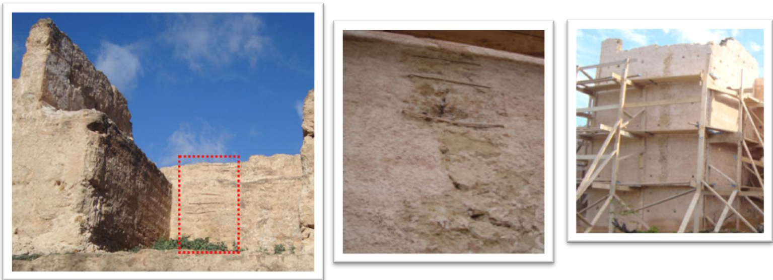
Figure 43 : colmatage de la fissure
