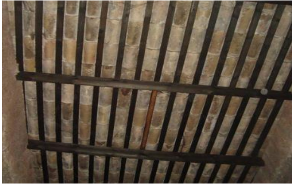
Figure 46 : vue sur la couverture intérieure
