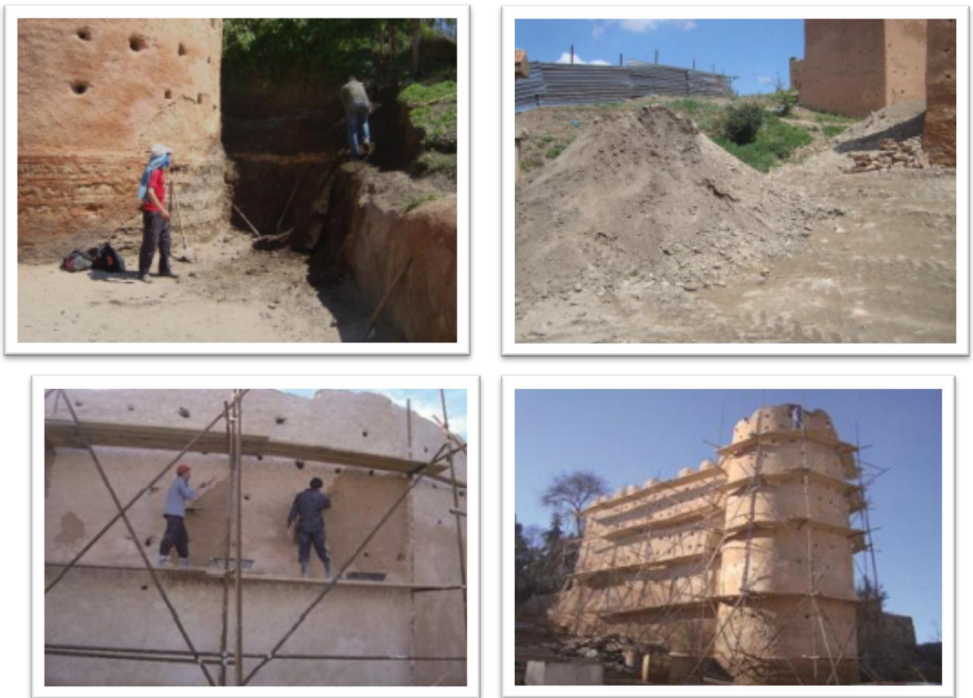
Figure 40 : vue sur les travaux de 2010
