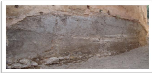
Figure 44 : reprise-en sous œuvre
