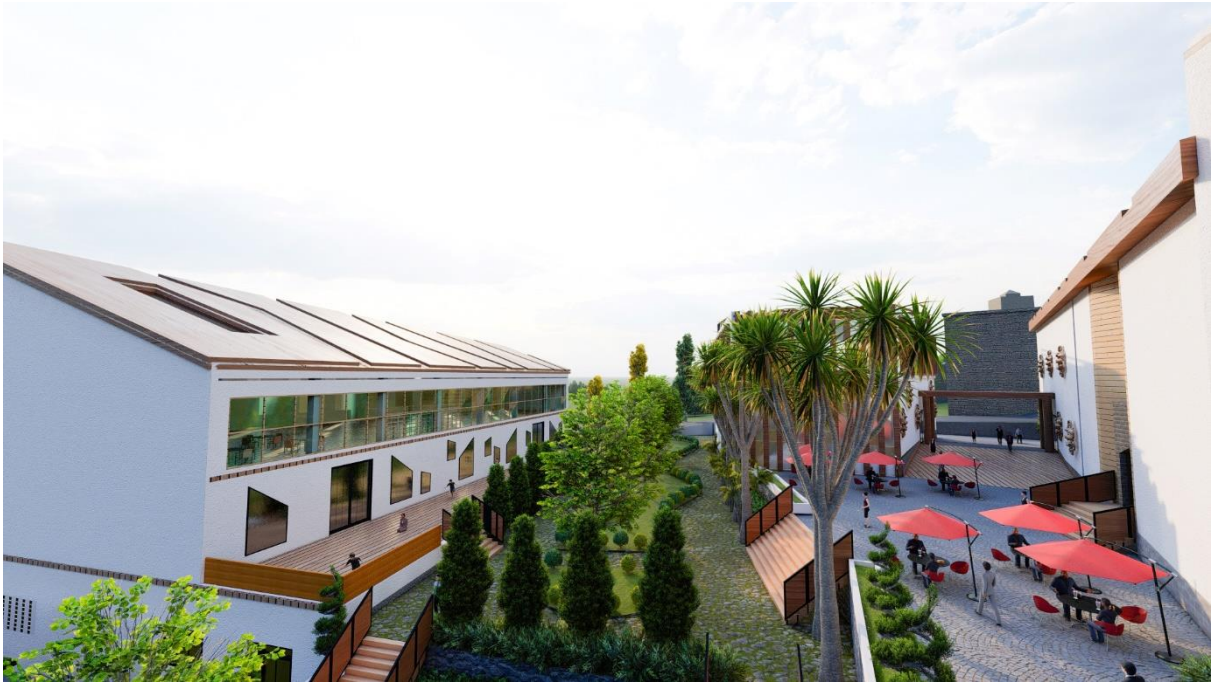
Figure 108 place centrale entre la bibliothèque et le restaurant
