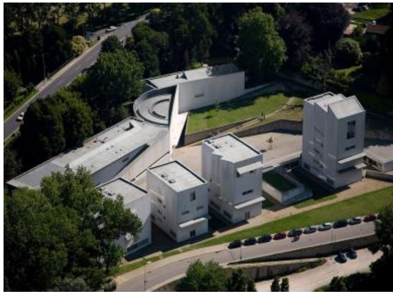
Vue aérienne de l'ensemble de la Faculté d'Architecture.
