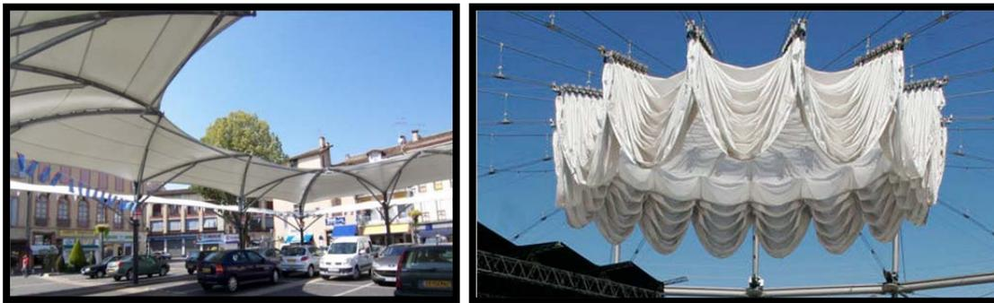
**Figure 127:** Structure métal textile avec un toit rétractable vers le centre
