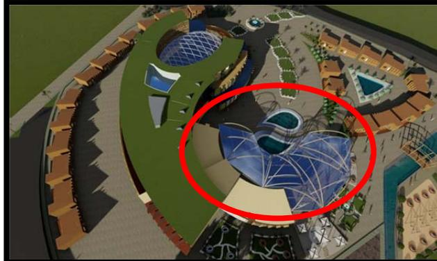
**Figure 126:** Structure métal textile avec un toit rétractable dans la partie Sud ouest du projet
