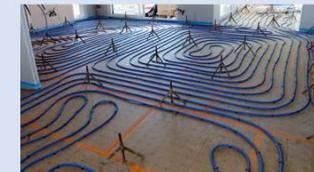
Les tuyaux de chauffage d'eau chaude sont fixés au treillis d'acier avant de couler le béton du plancher
