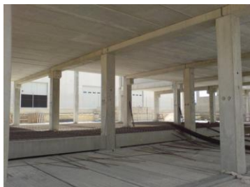
Figure 78. Structure en béton armé (Notion structures).
