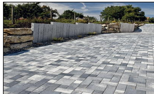
Figure 120 : pavé en béton gris. Source : Google internet.
