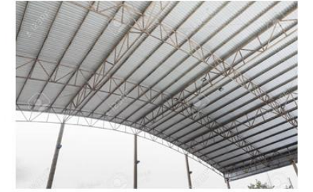
structure métallique pour la toiture d'amphithéâtre
