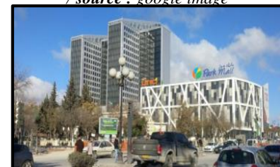
Figure 19 : Park mall, Sétif / source : google image
