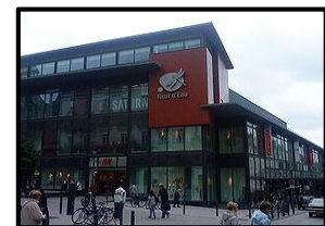
Figure 24 : Fleur d'Eau, France. / source : google image
