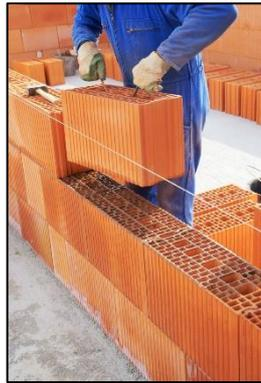
**Figure174.**Mur en brique en 15 cm.
