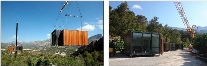
**Figure47.**La pose des cellules préfabriquées.
