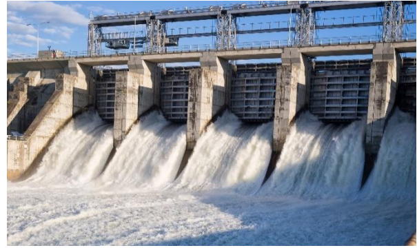
Figure24 : Exemple d'une centrale hydraulique. Source( https://www.mon-energie-verte.com/le-point-sur-lenergie-hydraulique/ )
