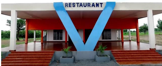
Figure48 : Façade du bloc de restauration. Source
