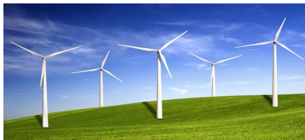
Figure23 : Des panneaux éolienne Source( https://lenergeek.com/2016/03/24/lassemblee-nationale-favorise-lenergie-eolienne/ )
