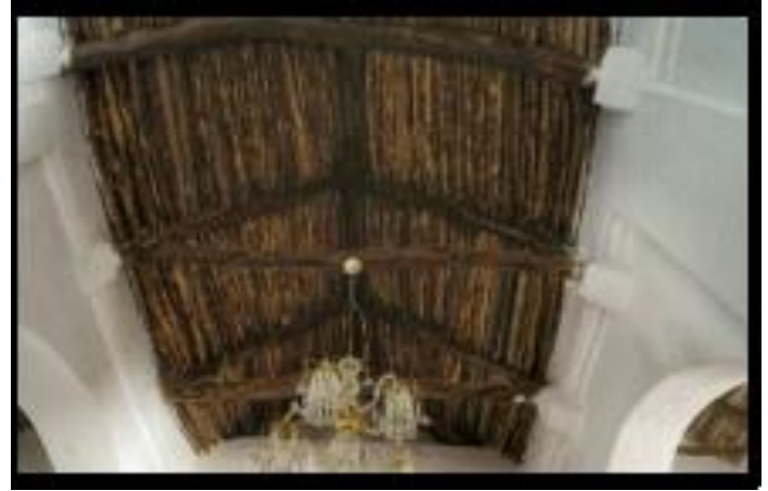
Figure 15: toiture de la mosquée à l'intérieur. Source: auteur. (15/01/2021)
