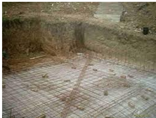
Figure 121. Ferrailage du radier d'une piscine 178
