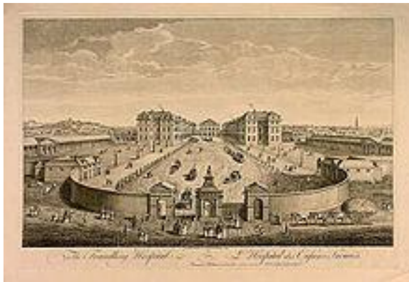
Figure 1 L'hôpital foundling (Le bâtiment a été démoli) 21
