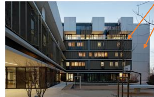
Figure 32. Façade «Eleanor Roosevelt» 95
