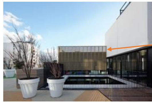
Figure 31. Façade avec du bardage métallique «Eleanor Roosevelt» 94
