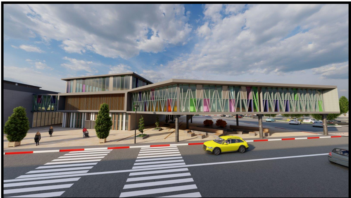
Vue la façade du Bloc D et C
