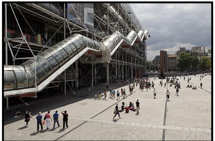
Figure 18: escalier extérieur du centre George Pompidou / source : centrepompidou.fr
