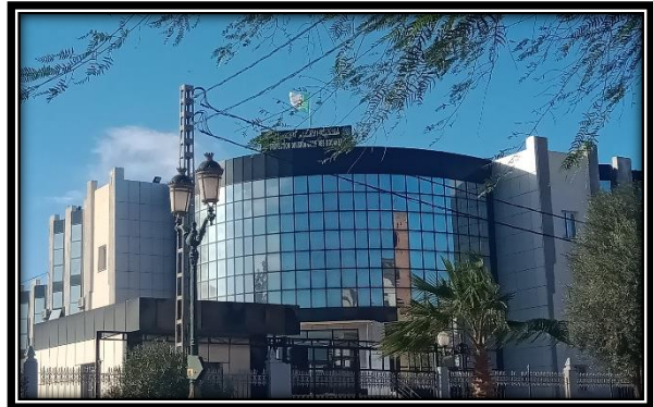
Figure 51: inspection de la douane a proximité / source: auteur.
