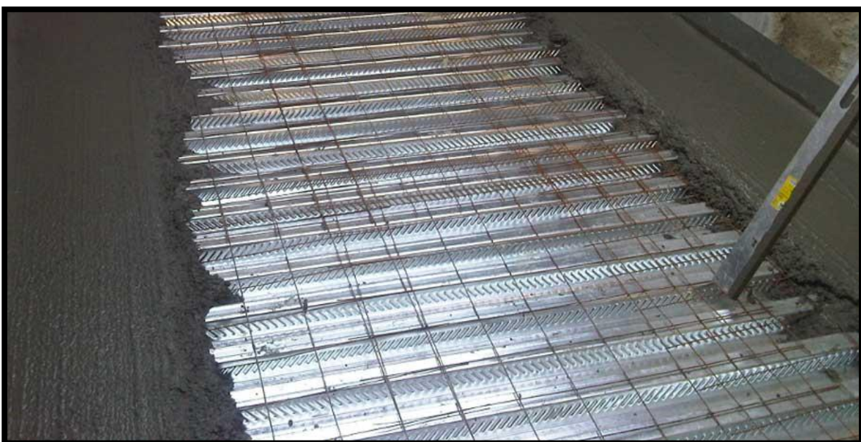
Figure 122: mis en place plancher collaborant / source : google image.
