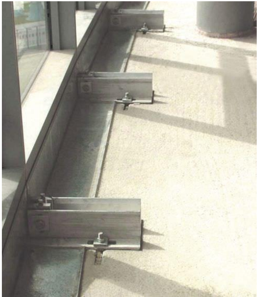
Figure 136: mis en place mur rideau / source : guidemurrideau.com
