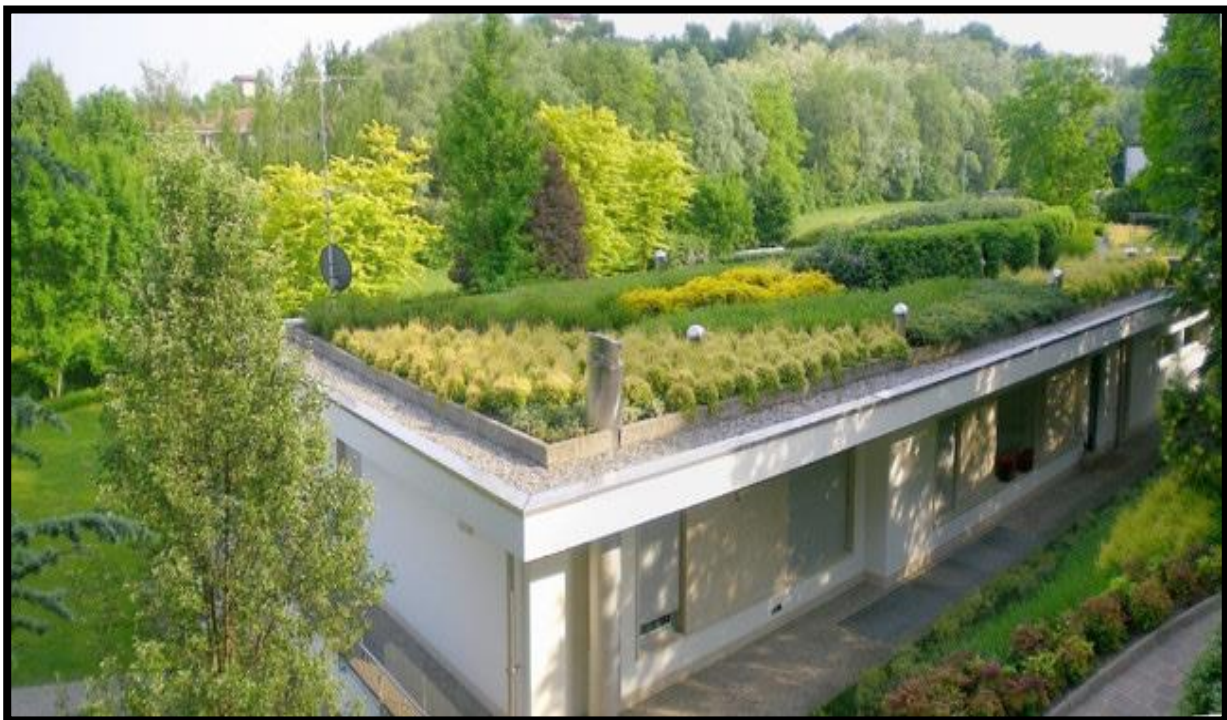
Figure 109: toit jardin / source : google image.
