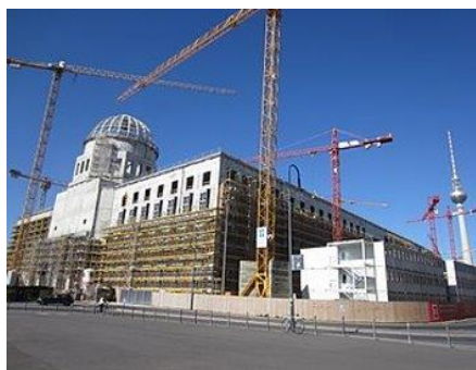
Figure 29. Les travaux de Château de Berlin
