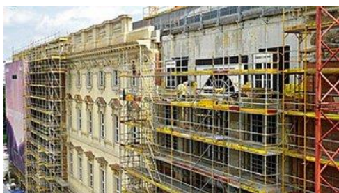
Figure 28. Les travaux de Château de Berlin
