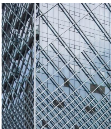
Figure 40. Une Façade structurelle
