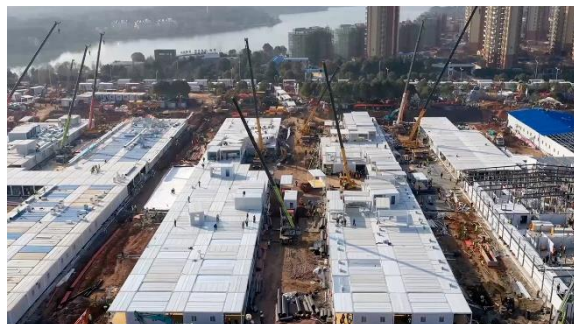
Figure 33. L'hôpital préfabriqué à Wuhan, Chine
