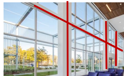
Figure 74. La structure apparente du centre
