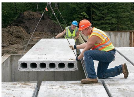
Figure 18. Dalles alvéolaires précontrainte préfabriquées
