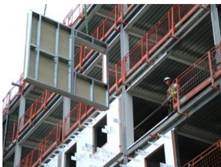
Figure 26. Panneaux muraux de remplissage en acier léger préfabriqué dans un bâtiment à charpente en acier
