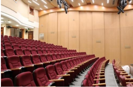
Figure 135. panneaux acoustiques en bois MDF
