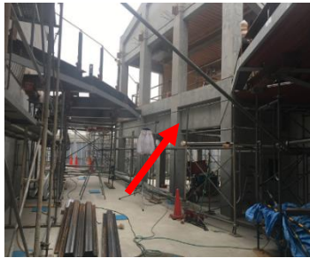
Figure 84. Les éléments verticaux de la structure
