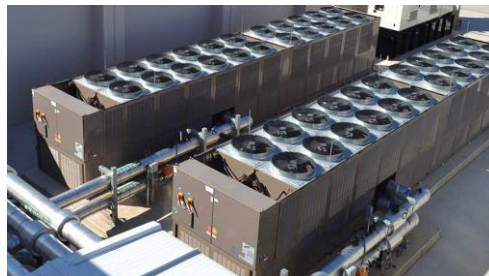
Figure 140. Un refroidisseur industriel à condensation par air (air-cooled chiller)
