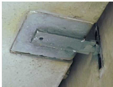
Figure 30. Plaques d'acier soudées sur panneau en béton
