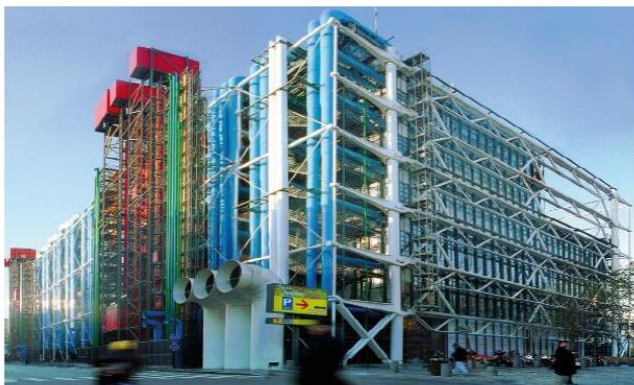
Figure 58. L'expression des différents système mécanique et électriques sur la façade
