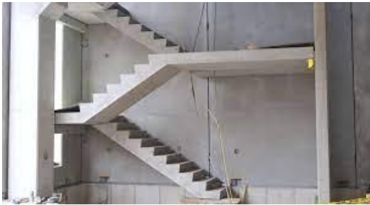
Figure 131. Escalier préfabriquées en béton
