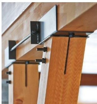
Figure 21. Les éléments d'assemblage et de connexion exposés
