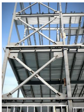
Figure 11. Un Contreventement en X
