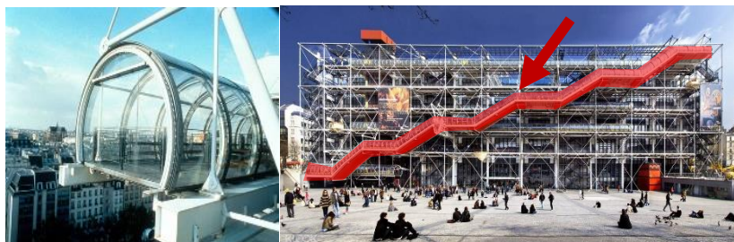
Figure 59. L'escalator sous forme de tube sur la façade
