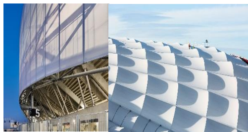
Figure 127 . membrane de fibre de verre PTFE di stade Stade Vélodrome à Marseille
