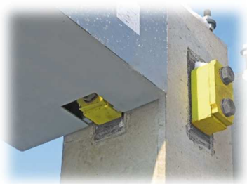
Figure 50: assemblage poteau-poutre avec le PCs
