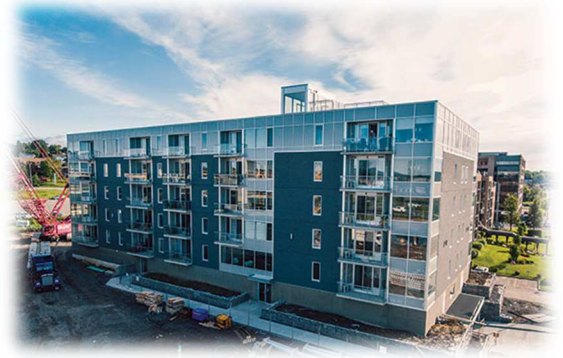
Figure 59: le bâtiment résidentiel au canada
