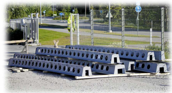
Figure 55: stockage de l'élément DELTA BEAM sur chantier
