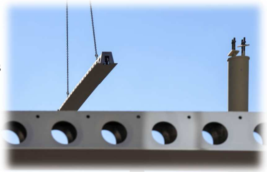
Figure 56: levage à l'aide es grues
