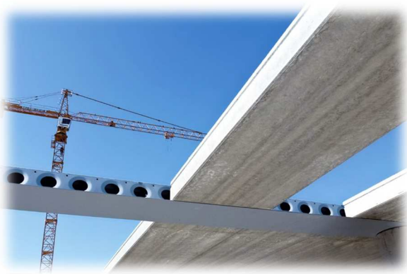
Figure 54: mise en place sur site
