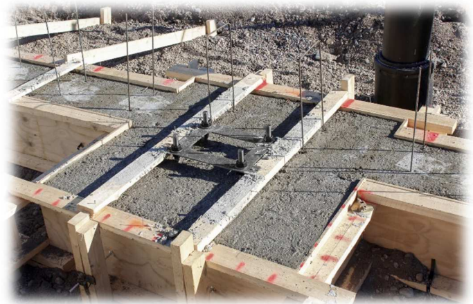
Figure 45: mise en place des PPL en phase de coffrage
