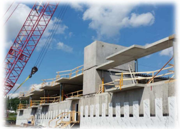
Figure 62: mise en place des balcons préfabriqués
