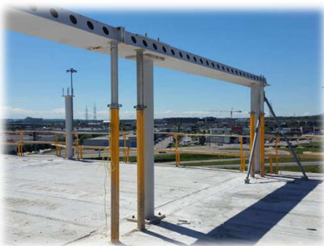
Figure 66: assemblage poteau poutre avec boulon PPL
