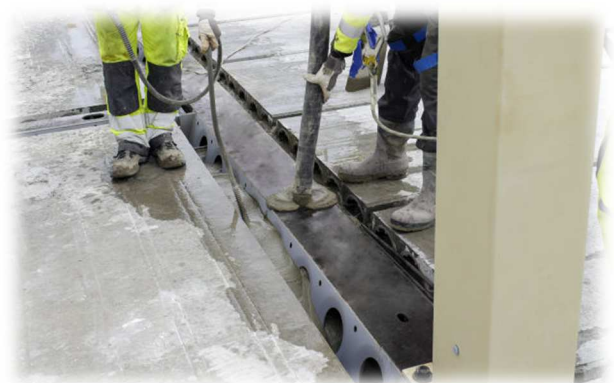
Figure 58: bétonnage du plancher avec les poutres
