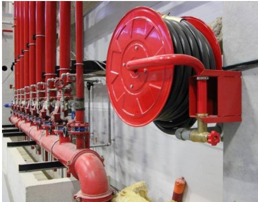
Figure 55 : RIA Robinet d'incendie armé
