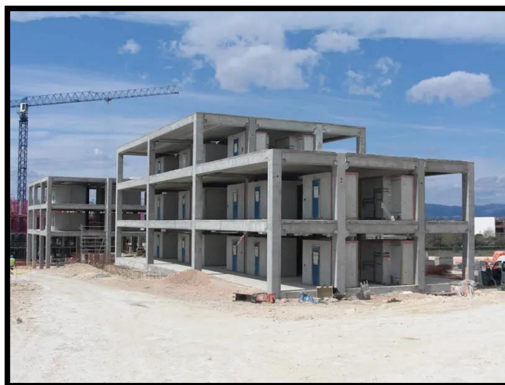
Figure 52: Structure en portique de béton armé
