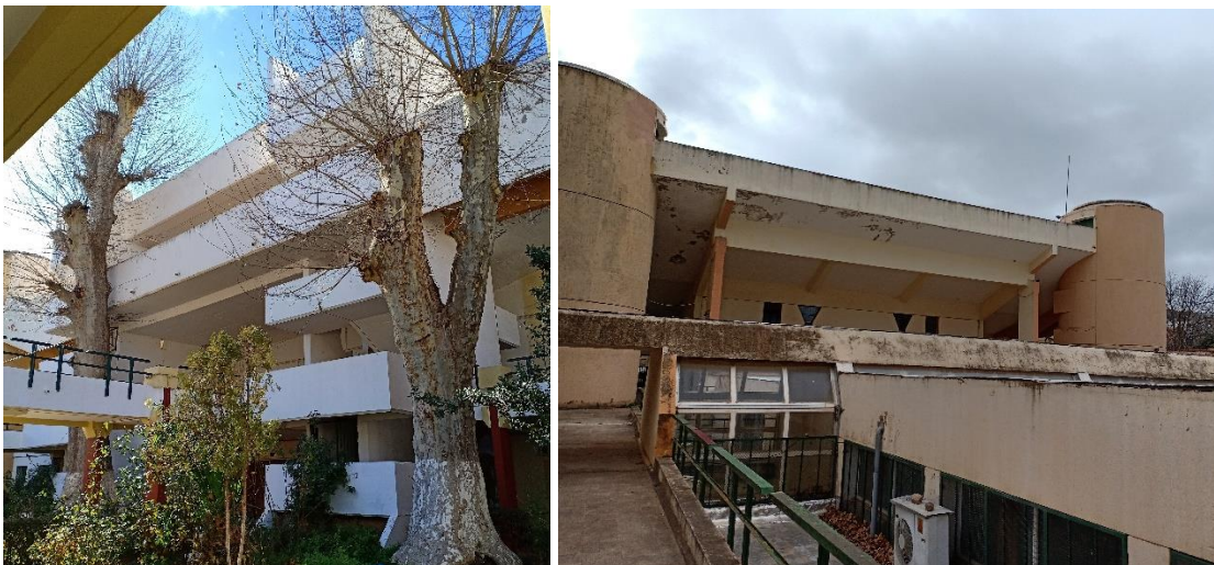
Figure 28: Le batiment à l'état actuel
