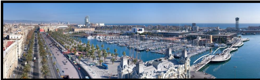
Figure 33 Vue panoramique du Port Vell, Source : https://www.shutterstock.com/fr/image-photo/port-vell-barcelona-viewed-elevation-26208397
