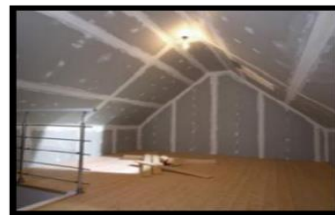
Les cloisons intérieures
